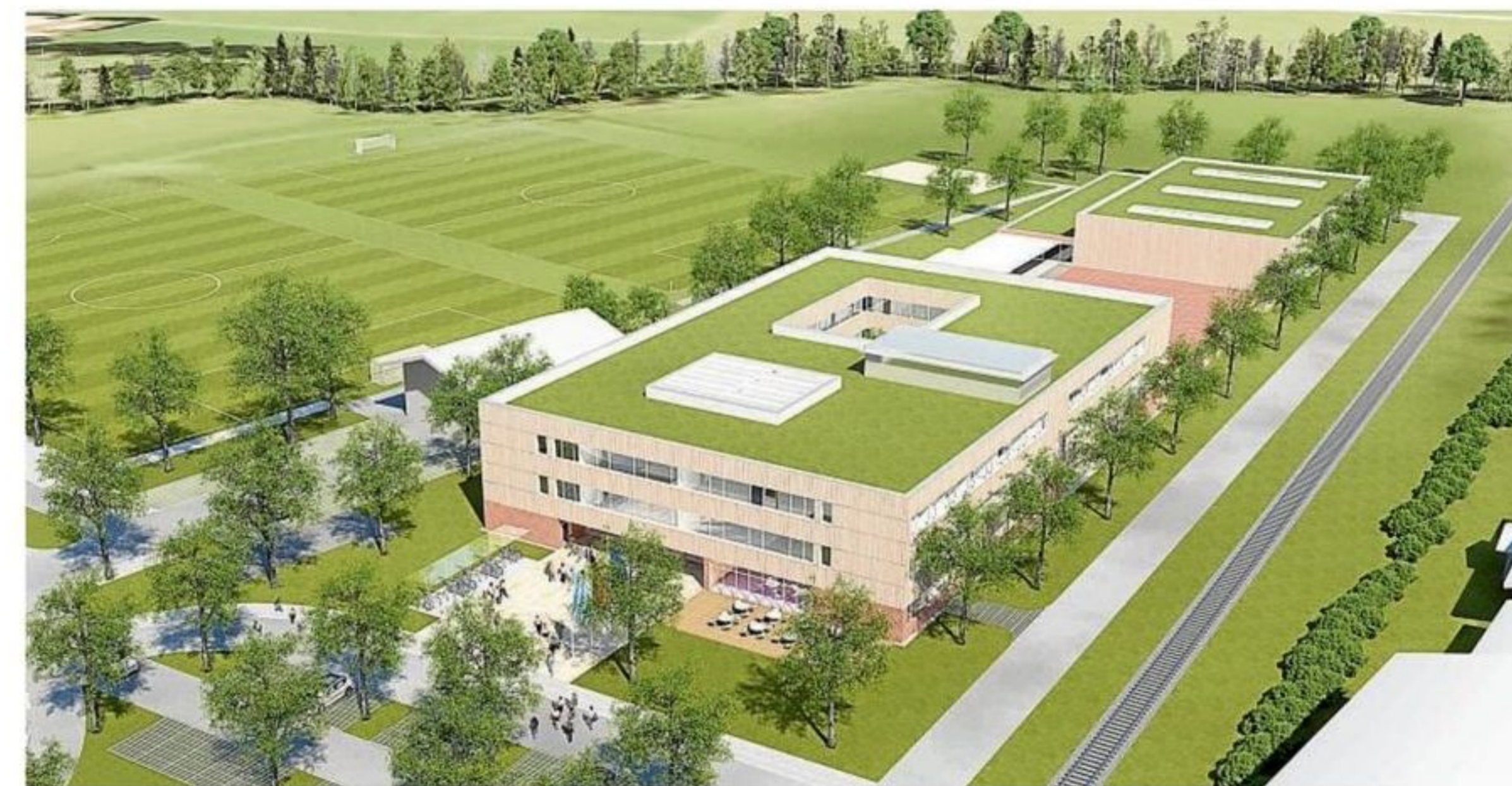
Zwei kompakte Baukörper: So sehen die Realschule (vorne) und die Dreifachturnhalle (hinten) künftig aus.
